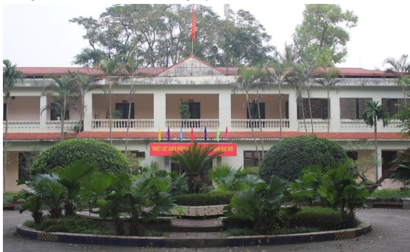
Khu hiệu bộ được cải tạo nâng cấp từ 1 tầng lên 2 tầng
