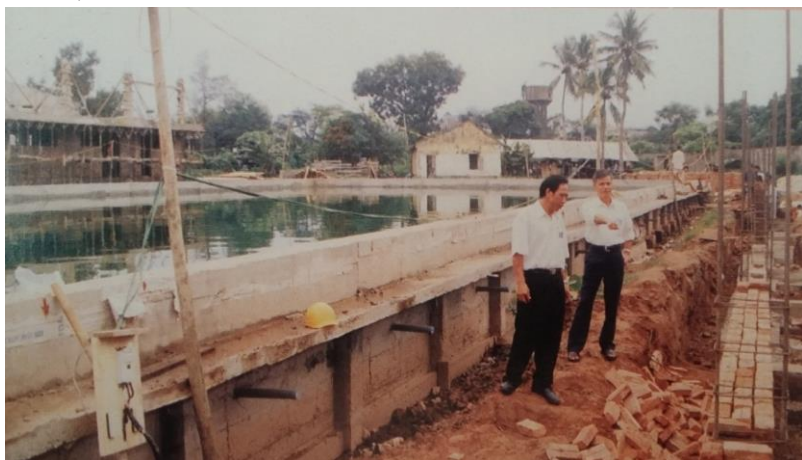
Kiểm tra chất lượng thi công bể bơi 50m- Năm 2001
